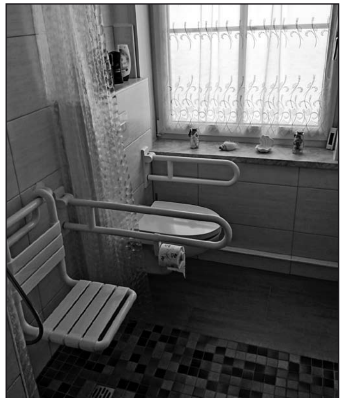
Die Wohnbau Johannegeorgenstadt GmbH setzte erste Bau- maßnahmen in ihrem Wohnungsbestand in der Neustadt um, wie z. B. dieser barrierefreie Badumbau.
